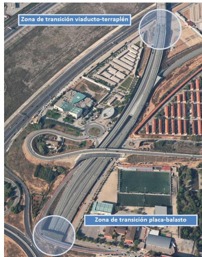
Zona monitorizada. Acceso Ferroviario Alta Velocidad a Valencia
